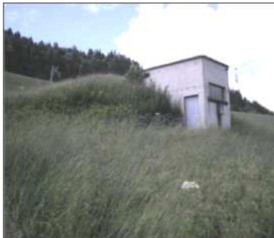
Figure 6 : Le réservoir des Varins, 500 m 3
