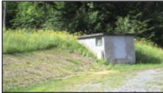
Figure 5 : Le réservoir des Grabilles, 200 m 3
