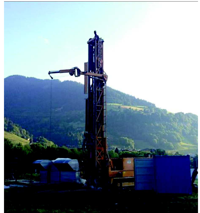
Forage des Varins en phase travaux
