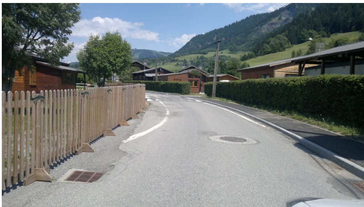
Photographie prise depuis la route du plan de Cassioz, sur le linéaire du réseau d'adduction
